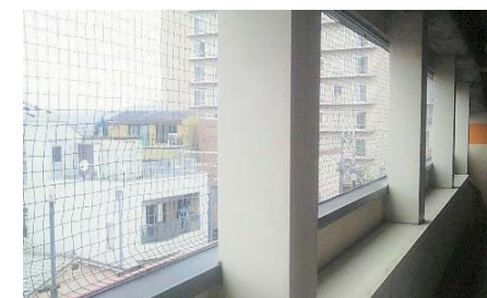
防鳥ネット取付工事
