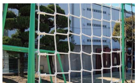
クライミングネット・ロープ工事
