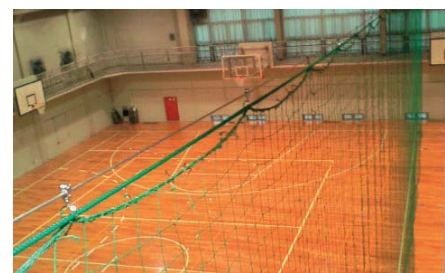
体育館ネット工事補修
