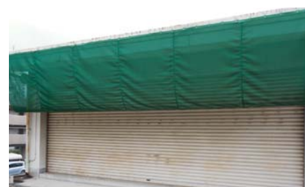
アーチェリーネット取付工事
