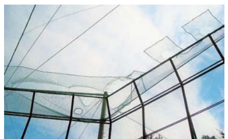
防球ネット工事補修
