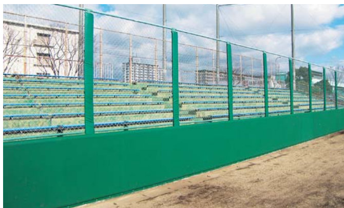
フェンス支柱防護パッド工事
