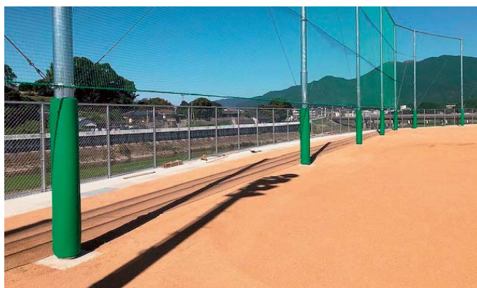
ポール防護パッド工事
