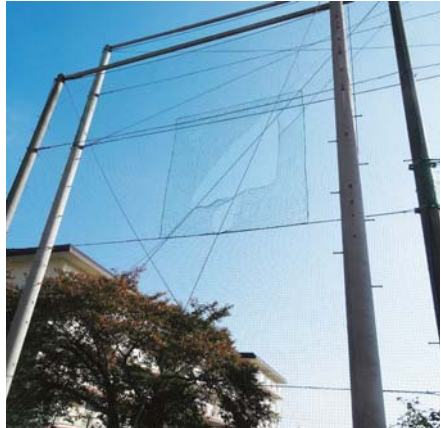
防球ネット補修工事
