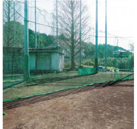
カーテン・ティネット設置工事
