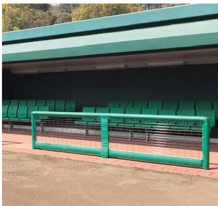
ダグアウト前フェンスパッド工事
