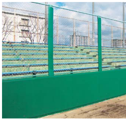
フェンス支柱防護パッド工事
