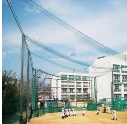
バックネット天井部分補修工事
